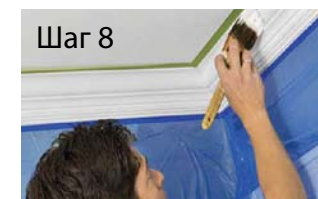
Шаг 8 Закройте стены и потолок тейп-лентой. Используя кисточку, покрасьте краской карниз.
