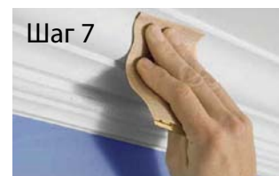
Шаг 7 Для шлифовки поверхности используйте наждачную бумагу.
