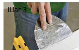
Шаг 3 Нанесите клей вдоль по краям обратной стороны карниза, а также на поверхность, которую будете клеить.
