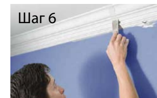
Шаг 6 С помощью ножика для замазки швов, обработайте стыки соединений.
