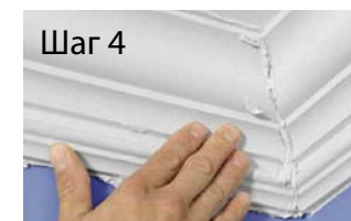
Шаг 4 Соедините оба карниза вместе, чтобы их профили совпали. Используйте остатки клея, чтобы замазать трещины между карнизами.
