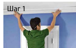
Шаг 1 Сделайте отметки карандашом на стене, чтобы определить местоположение карниза.
