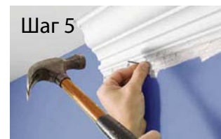
Шаг 5 Перед тем как забить гвозди, убедитесь в ровности соединения.
